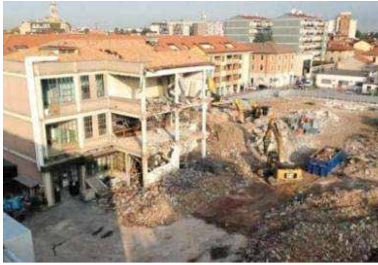
Figura 7: Attività di demolizione
