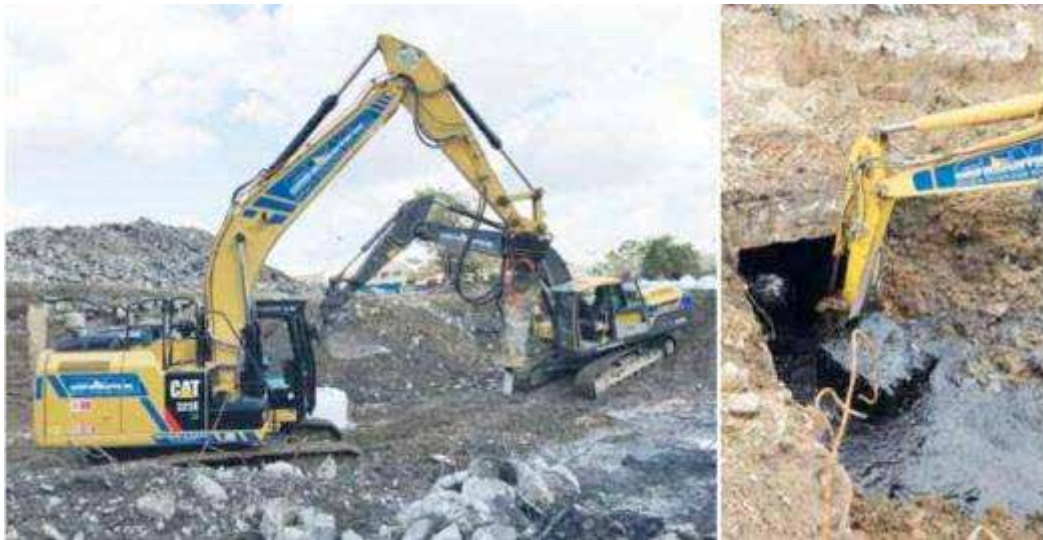
Figura 5: Attività di scavo per bonifica ambientale
