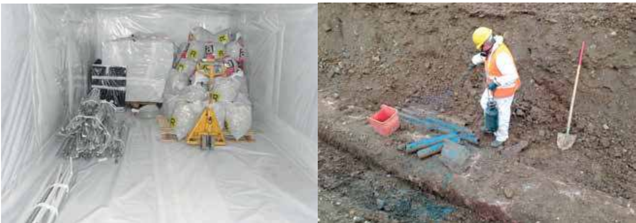
Figura 6: Attività di bonifiche amianto
