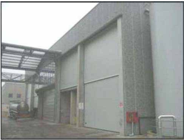
Figura 3. Vista esterna ed interna dell'impianto di trattamento acque
